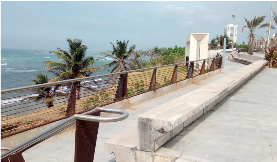
Abb. 6+7: PASEO DE PUERTA DE TIERRA, corrosion and decay, Lisa Ladner, 2020
